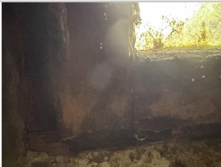
Escalier n°1(1er SS) : Fenêtre Ouvrant Intérieur Toutes zones (Bois - Peinture)
