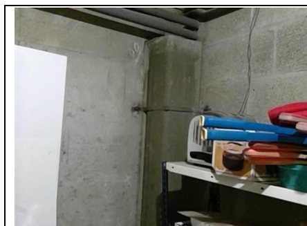
Photo n° PhA001 Localisation : Remise Ouvrage : 6 - Conduits et accessoires intérieurs - Conduits de fluides (air, eau, vapeur, fumée, échappement, autres fluides) Partie d'ouvrage : Conduit en fibres-ciment Description : Conduit en fibres-ciment Localisation sur croquis : M001
