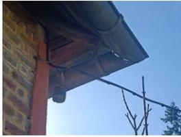
Système d'évacuation des eaux pluviales dégradée et/ou bouchée. Ces désordres peuvent être, par la suite, à l'origine de pathologies
