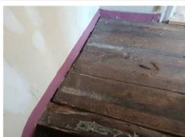
Plancher palier 1er étage dégradé (plancher des chambre non visible parquet flottant)
