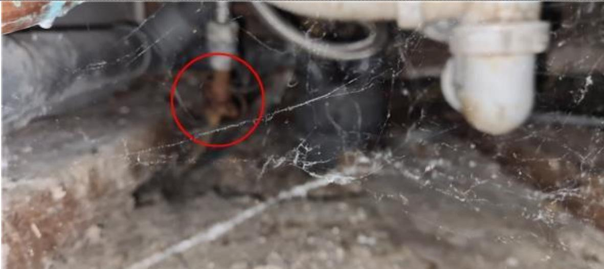
**Description :** Locaux contenant une baignoire ou une douche: au moins une CONNEXION du CONDUCTEUR de LIAISON EQUIPOTENTIELLE supplémentaire, à un élément conducteur et/ou une MASSE et/ou une broche de terre d'un socle de prise de courant n'assure un contact sûr et durable.
